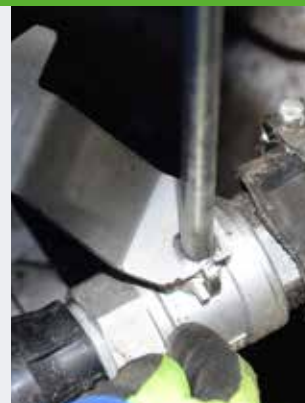
► Installation Kugelhahngriff
